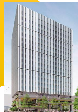
アーバンネット仙台中央ビル (2023年11月竣工予定)
